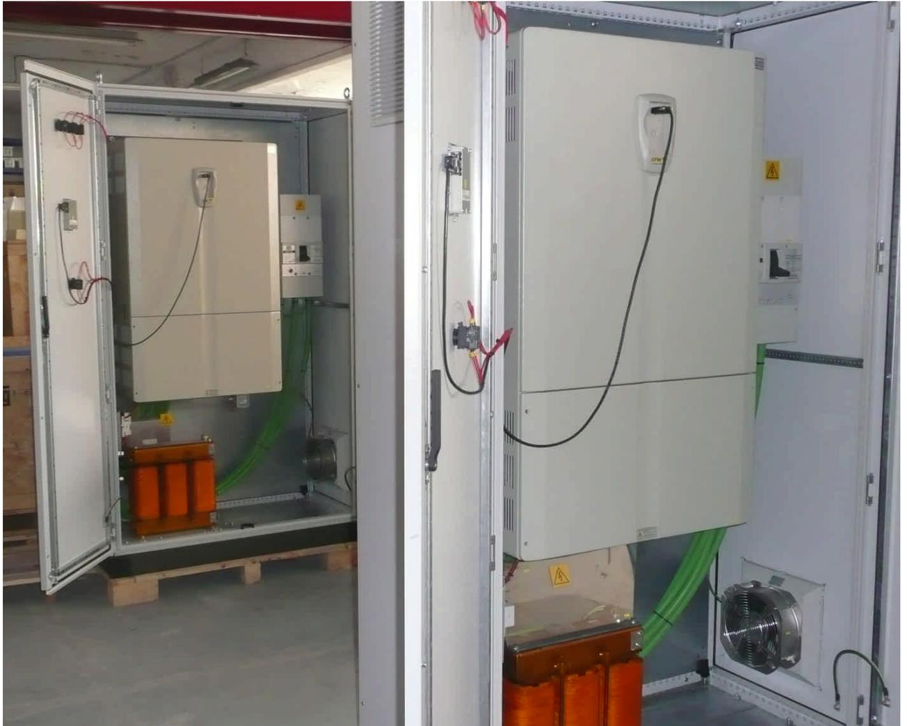
**Armarios con convertidores de frecuencia WEG de 600A para la regulación de velocidad motor trifásico de sistema de bombeo.**
